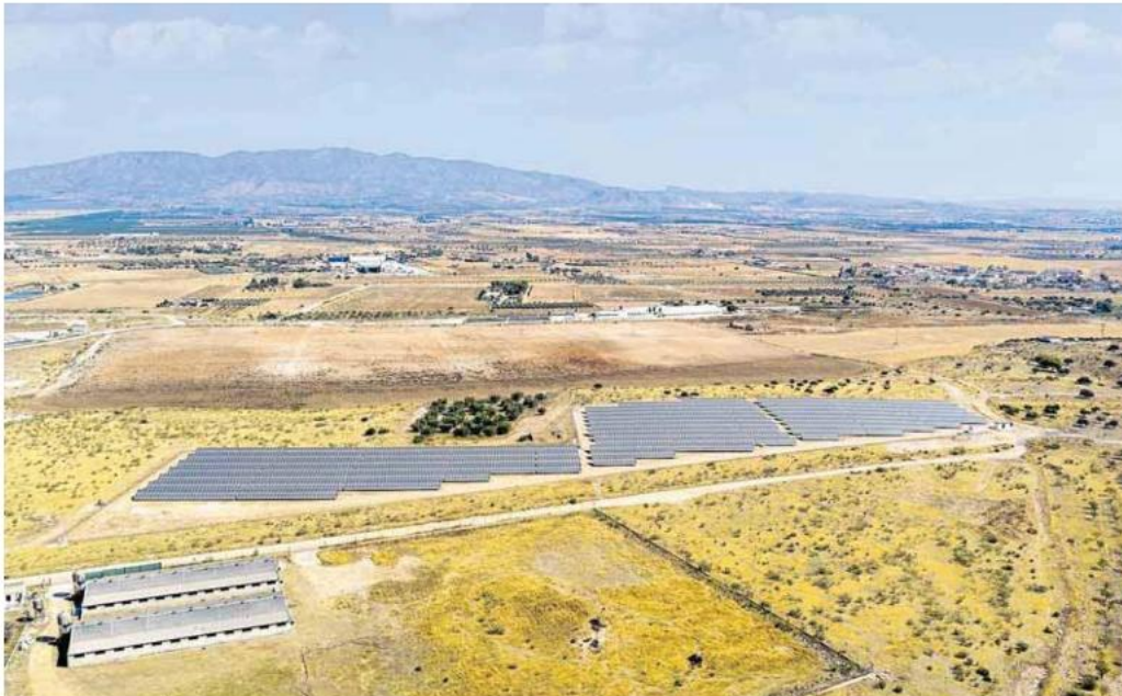
Planta fotovoltaica de Álamo I, ya construida en Murcia y que Pitma Generación pondrá en marcha en el tercer trimestre. DM
